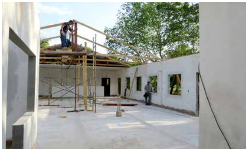
Bau der Bibliothek und des Informatikraumes im CEIYS
