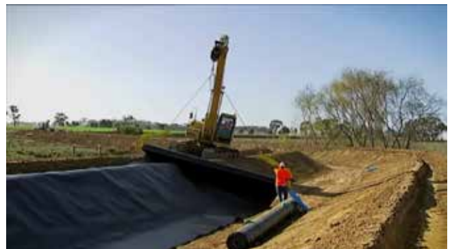
Ein Kanal der mit einer Geomembrane beschichtet wird
